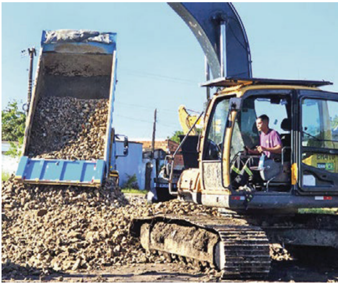
A Prefeitura de Itanhaém iniciou nesta segunda as obras de desassoreamento do Rio Campininha
